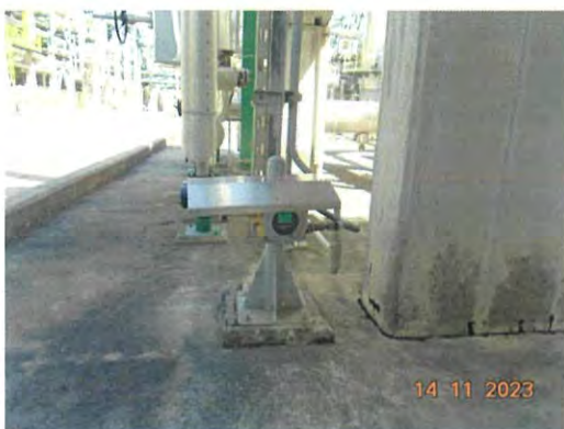
อุปกรณ์ตรวจจับก๊าซ (Gas Detector)
