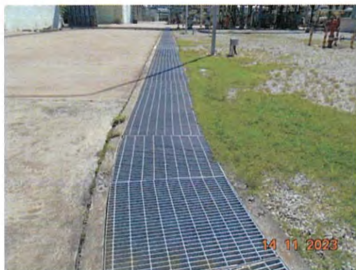
รูปที่ 2-10 ระบบระบายน้ำฝน
