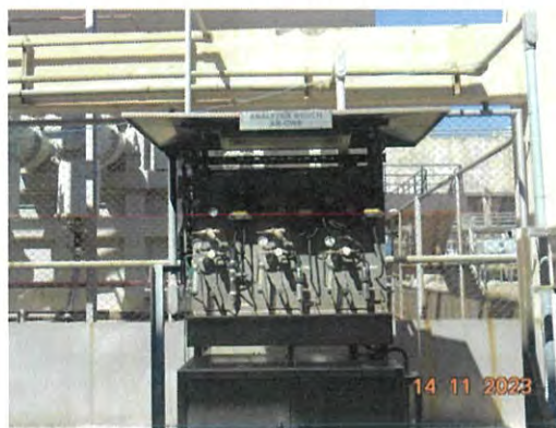
การติดตั้ง ORP Analyzer ที่ระบบ Cooling Water System-3
