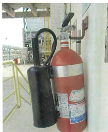
ถังดับเพลิงแบบมือถือ (Portable Cry Chemical Fire Extinguisher)
