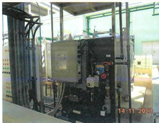
การติดตั้ง ORP Analyzer ที่ระบบ Cooling Water System-2
