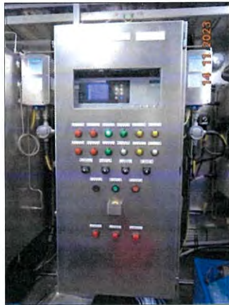
รูปที่ 2-1 ระบบ CEMs ที่ปล่อง H-100H
