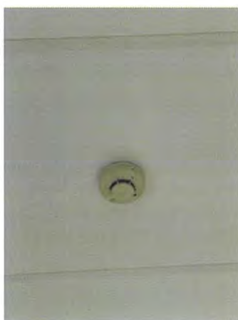
อุปกรณ์ตรวจสอบความร้อน (Heat Detector)
